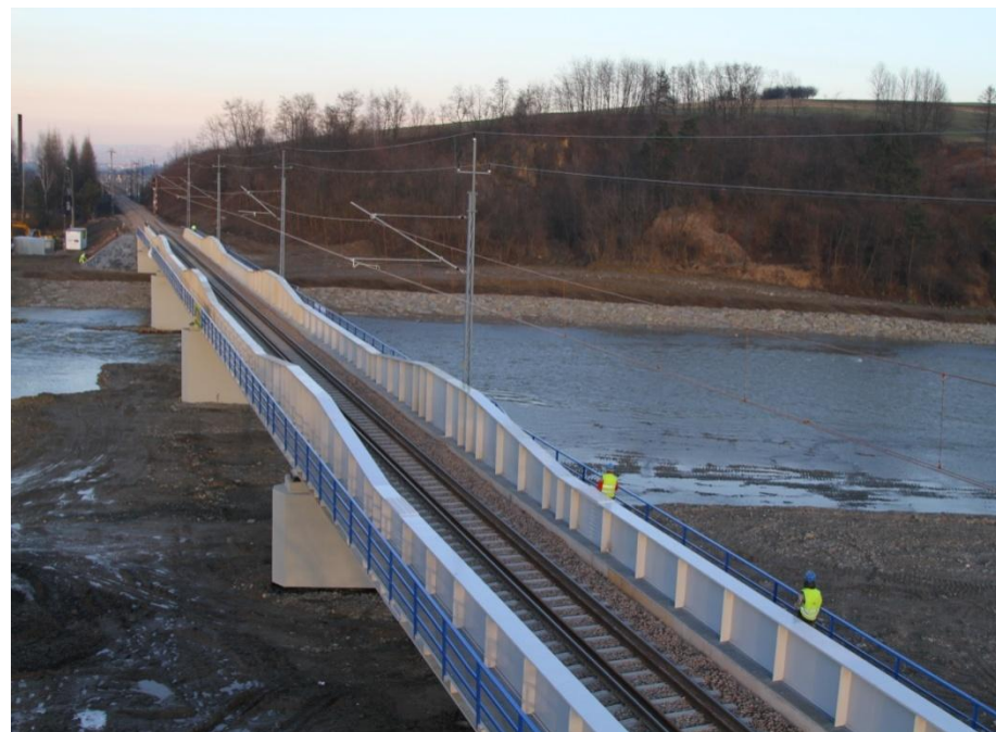
Linia kolejowa nr 96 km 93,136 - most na rzece Poprad
