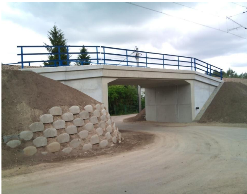
Linia kolejowa nr 109 Kraków – Bieżanów – Wieliczka – wiadukt kolejowy
